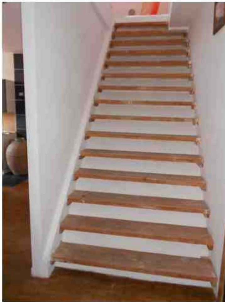
Foto N. 30.- Scale interne d'accesso al livello sottotetto
