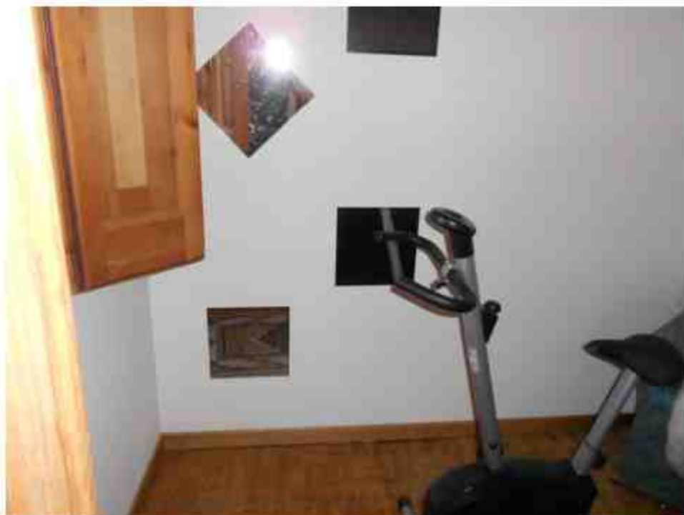
Foto N. 36.- livello sottotetto, vano laterale
