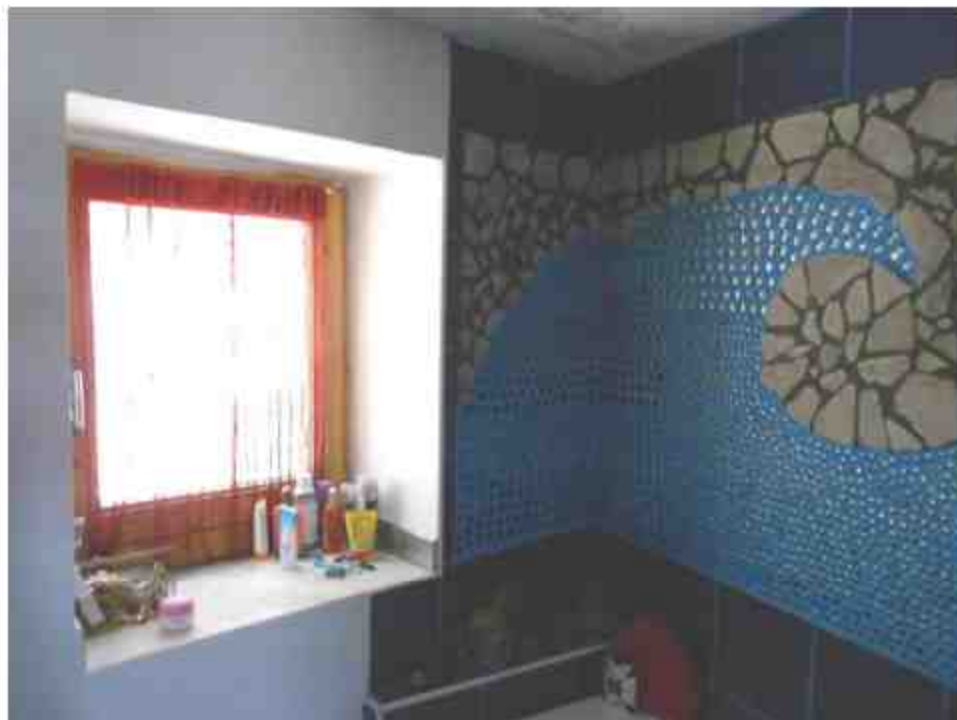
Foto N. 21.- Primo livello- WC
