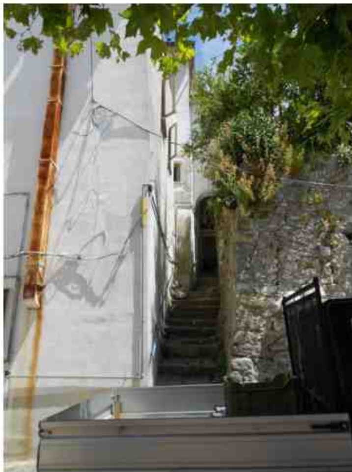
Foto N. 1.- Zona di ubicazione dell'appartamento oggetto di E.I.
